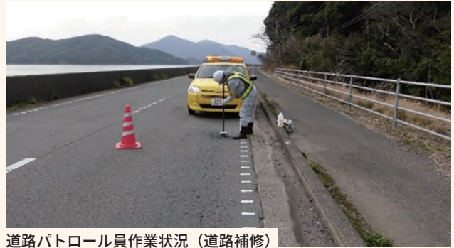
道路パトロール員作業状況 (道路補修)
