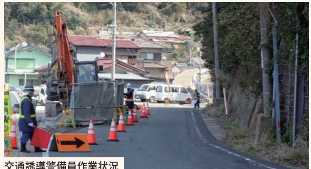
交通誘導警備員作業状況
